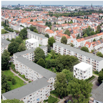
Abbildung 17: „Bremer Punkt“ der Wohnungsbaugesellschaft GEWOBA Bremen, Abbildung © LIN
