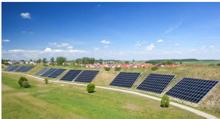
Abbildung 4-4 Freiflächen-Solarthermieanlage in Crailsheim (Quelle: www.sonnewindwaerme.de/solarthermie/solare-waermenetze-baden-wuerttemberg )
